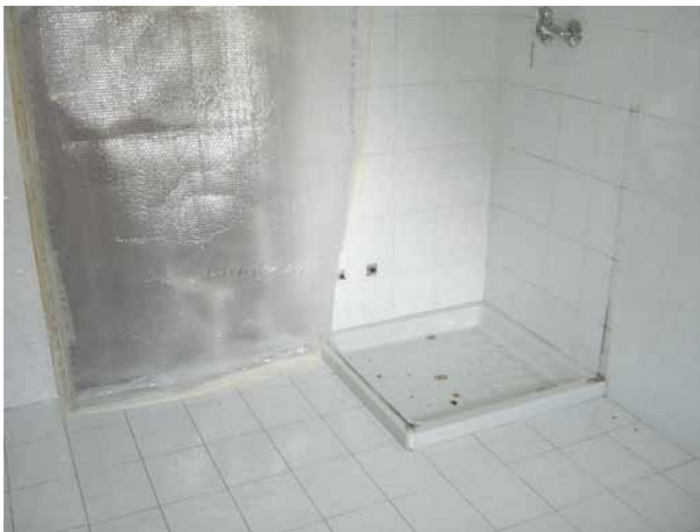
Vano doccia prima dell'intervento di ristrutturazione.
